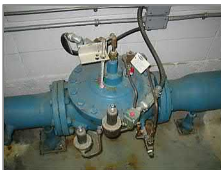
Rebuild PSV/PRV
